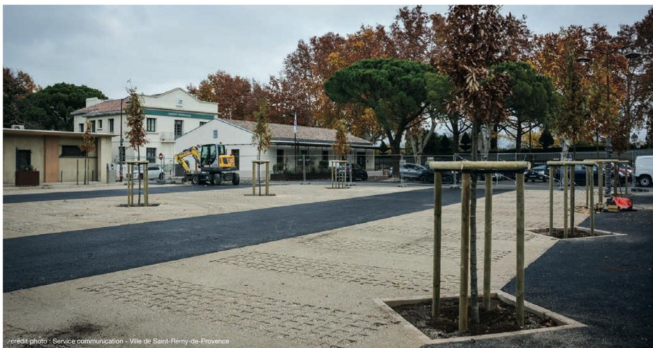
La ville de Saint-Rémy-de-Provence a aménagé un parking en centre-ville selon le principe de déconnexion du réseau des eaux pluviales et infiltration dans un sous-sol drainant. Les 4 pins enlevés ont été remplacés par 11 chênes chevelus, qui apporteront davantage d'ombre, et dont les racines ne détériorent pas le sol.
