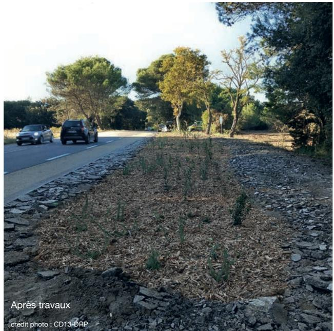
Désimperméabilisation d'un délaissé de la RD26 à Plan d'Orgon : une partie de la structure de la chaussée a été broyée et laissée en place pour constituer les bordures de l'espace végétalisé. Sur 50 cm de profondeur, le sol a été ameubli pour permettre l'enracinement profond, avec apport de terre végétale en réservant 10 cm de décaissé pour recueillir les eaux de ruissellement, comblé avec une couche protectrice de bois broyé.
