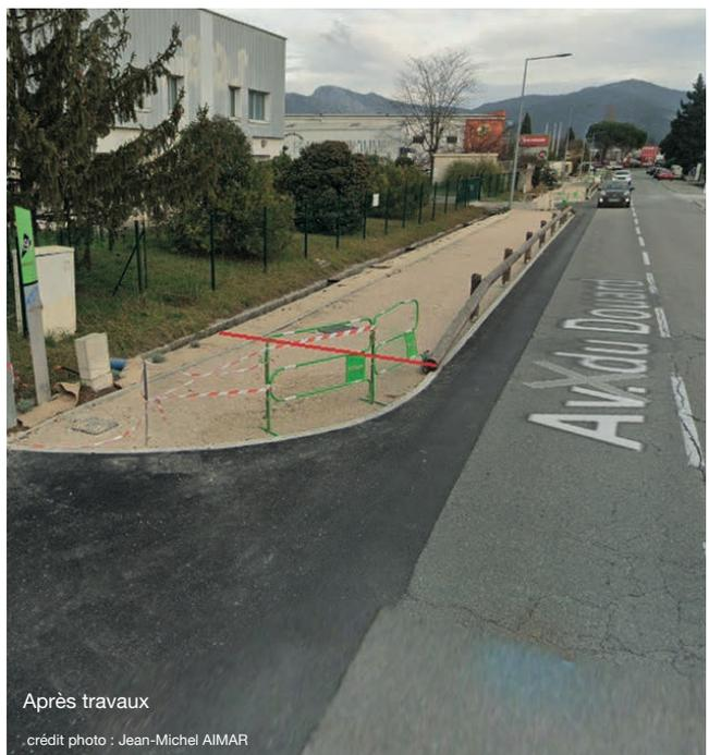
La Métropole s'engage dans des projets de désimperméabilisation de voies douces, comme ici dans la zone des Paluds à Aubagne, où une résine perméable est utilisée.
